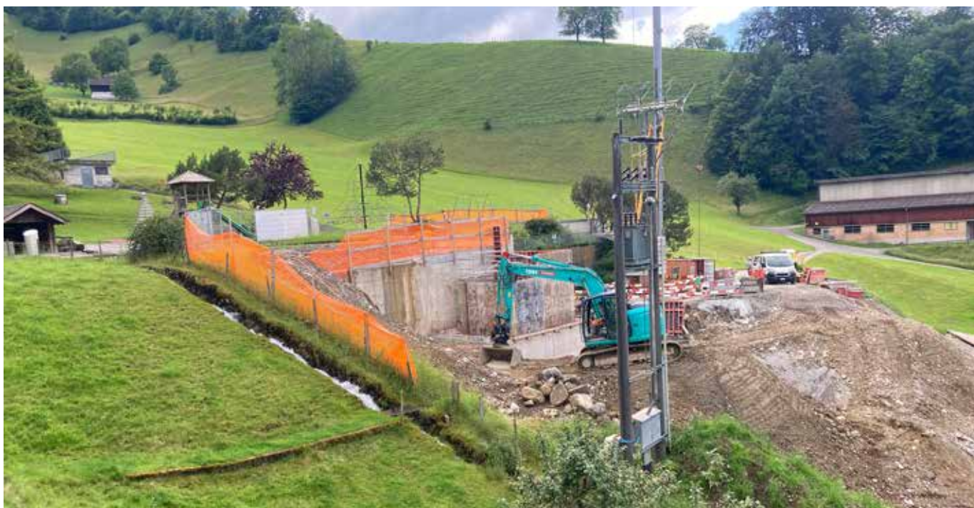
Die Baustelle Klostermatt, Bilder: Peter Steiner
